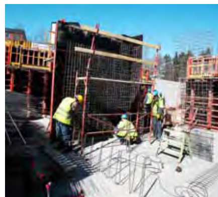
I kvarteret Ekipaget i Edsberg, bygger Sollentunahem tre huskroppar för totalt 100 vårdboenden.
