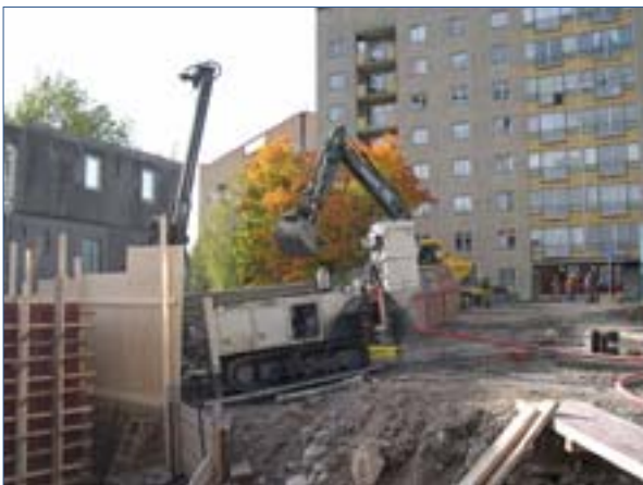
Borrning för bergvärme i kvarteret Ellipsen, Edsberg
