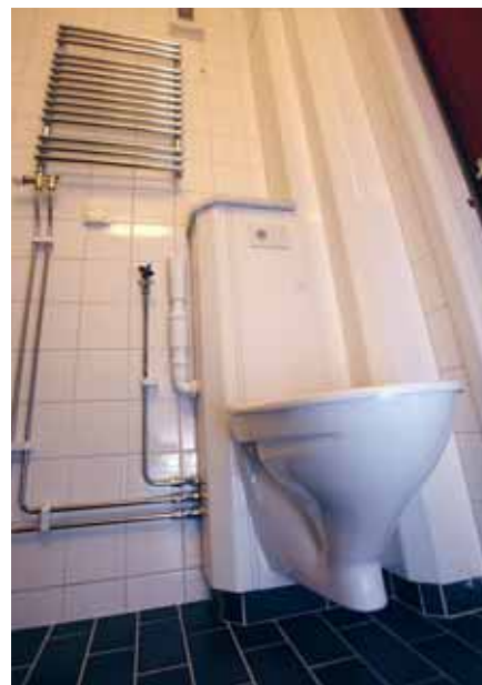
Våtrums-kassetterna möjliggör vägghängda toaletter och tvättstall som ansluts till avloppssystemet ovan golv och ger ett lättstädat våtrum.
